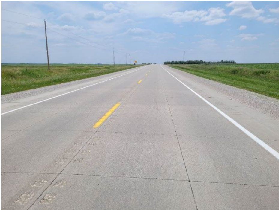
Whitetopping overlay section
