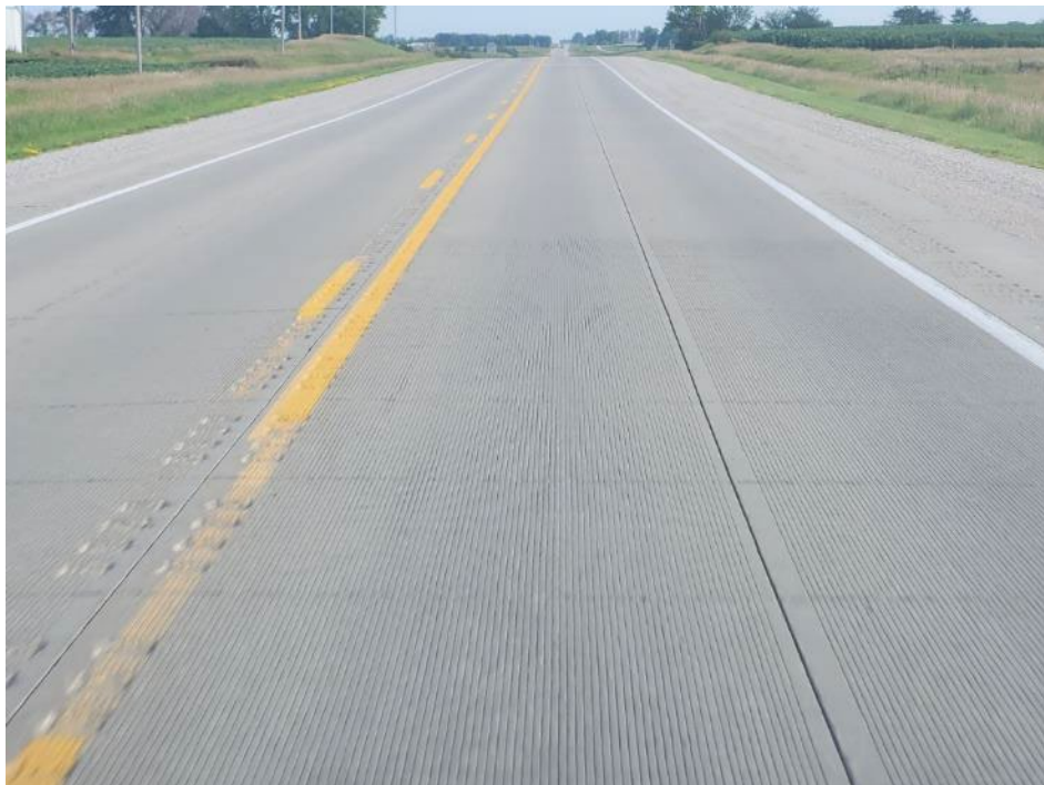
Whitetopping Overlay section
