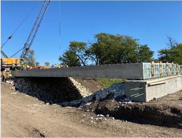
(d) Bridge before placement of joint concrete
