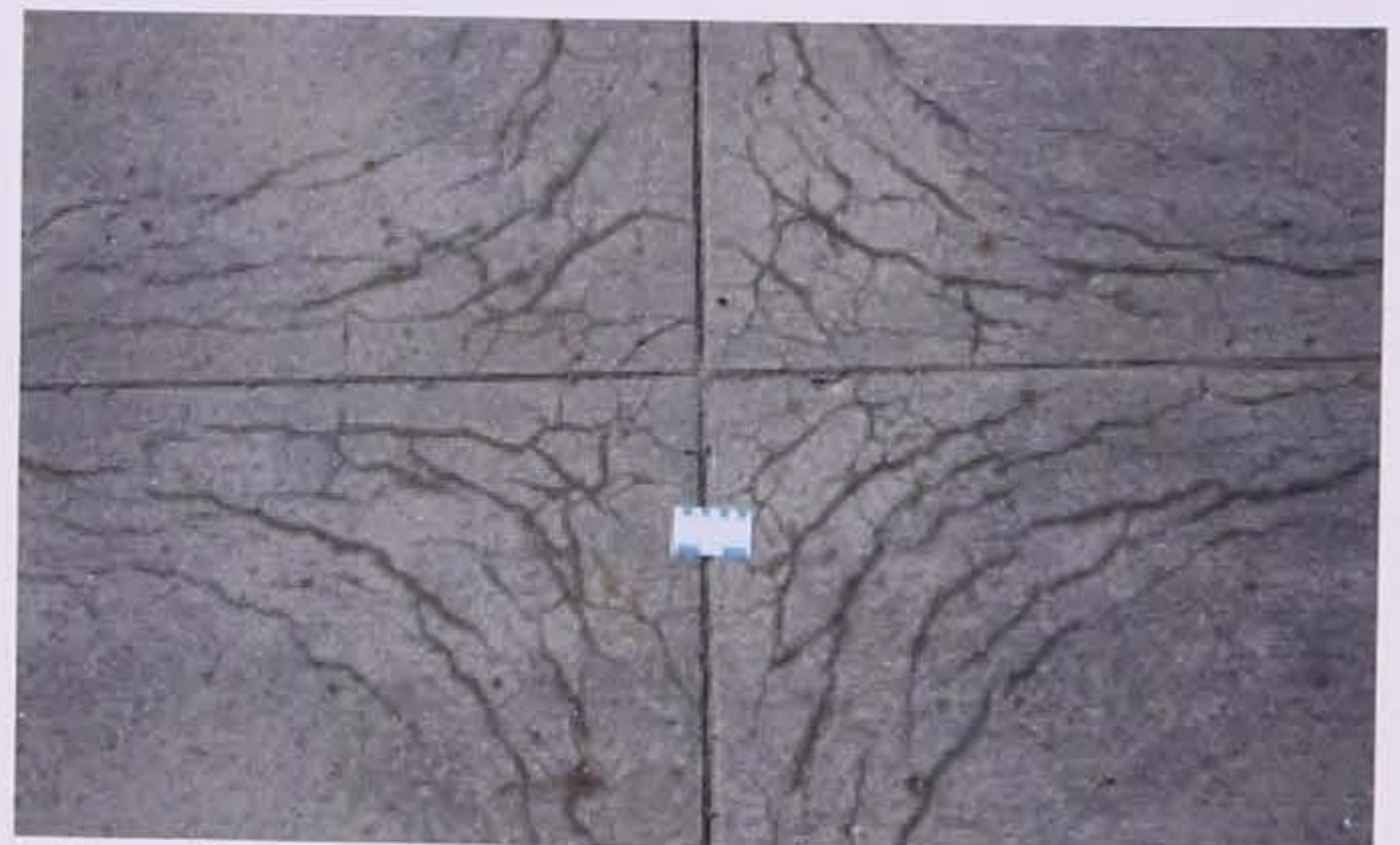
h. D-cracking
