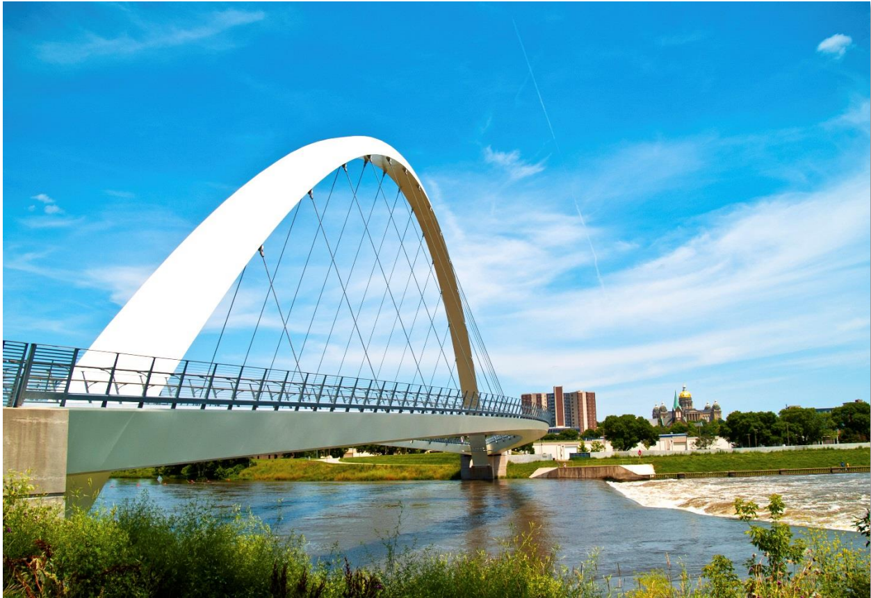
Des Moines walking bridge
