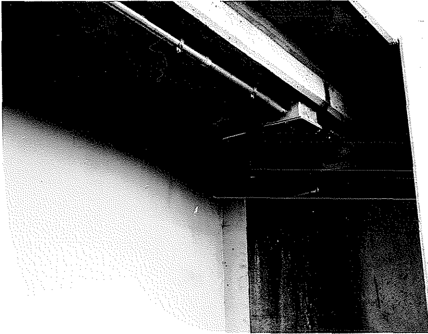
Figure 16 - Conduit runs
