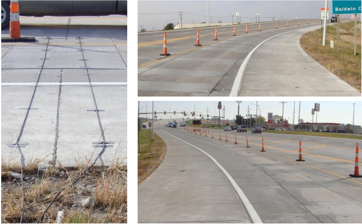
Figure 3.12. US-56 WB site setup photos
