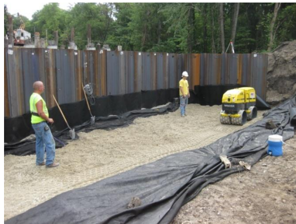
b.) Vibratory compaction
