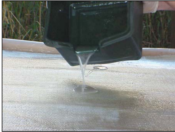
Figure A.27 Pour epoxy directly onto the fiber sheet.
