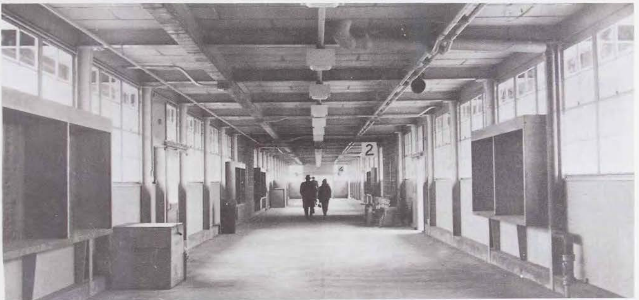
Enclosed concourse, Des Moines Municipal Airport, 1959. (Courtesy: Des Moines Municipal Airport)
